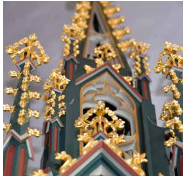
Detail der fertig montierten Fialen des Hauptturms und der vergoldeten Kleinteile
