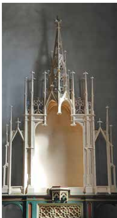
Rechter Altar in Rohholz zum Probelauf in der Kirche aufgestellt
