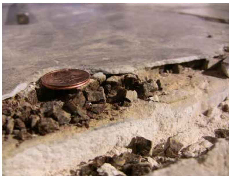
Aufbau und Zustand einer inkrustierten Bodenplatte im Marmorsaal des Neuen Palais. Foto: Lutz Schummel, SPSG
