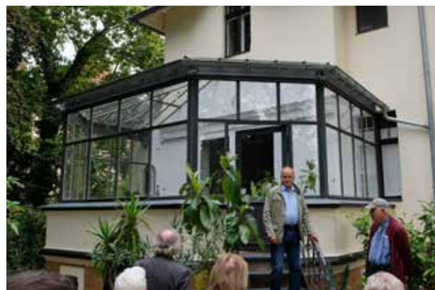
Restaurierter Wintergarten Berlin Lichterfelde. Herr Becker schildert seine Restaurierungsarbeiten
