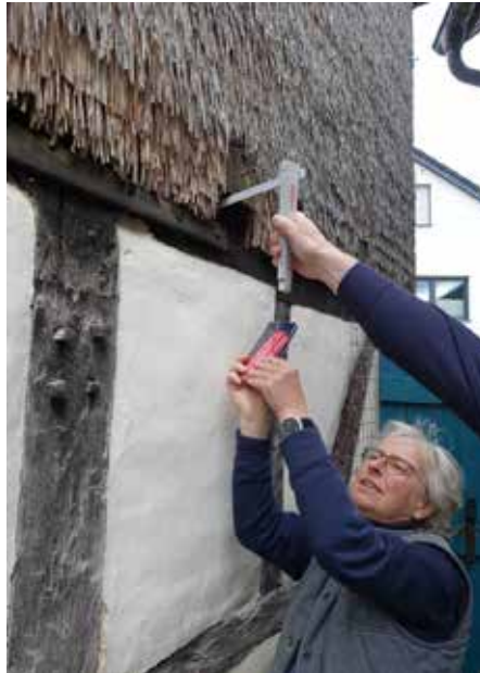
Fotografische Aufnahme eines ca. 25 Jahre alten Strohhalm-Behangs, einer regionale Bauspezialität
