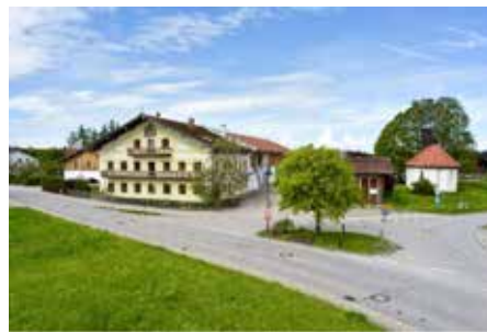
Der Firmensitz in Kirchstockach ermöglicht Arbeiten auf 3.000 Quadratmetern im historischen Gemäuer
