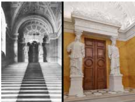
„Je komplexer, desto mehr Spaß“ – diese Devise galt schon immer bei RSP. Residenz München, Rekonstruktion der Portaltür im Gelben Treppenhaus im Jahr 2021. Foto:© Bayerische Schlösserverwaltung (www.schloesser.bayern.de)
