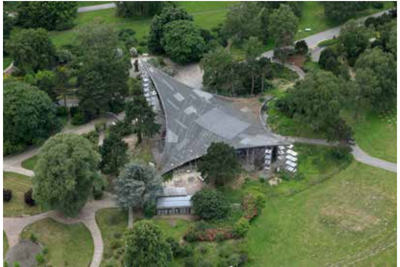
Abb. 2 Beginn der Instandsetzungsarbeiten
