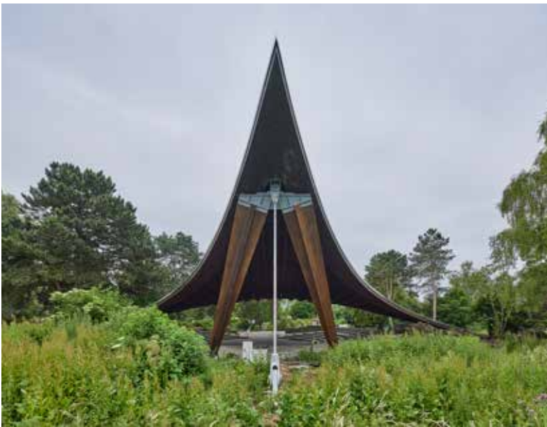
Abb. 1 Das „Sonnensegel“ nach der Instandsetzung
