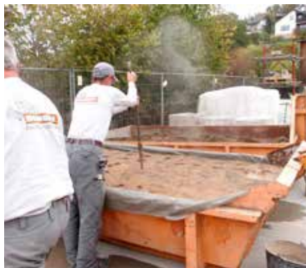
Kalkspatzenmörtel klassisch angemischt
