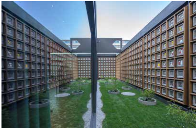
Abb. 7 Kapellenumgang nach der Instandsetzung
