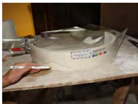
◀ Nachzeichnen der durchgepausten noch vorhandenen Originalfragmente
