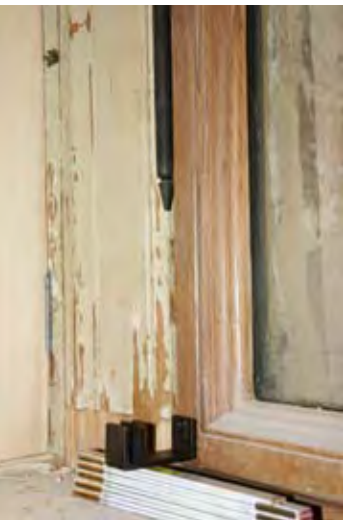
Mechanische Verschattungsanlage unterhalb der Drillingsfenster im Bacchusaal ▼
