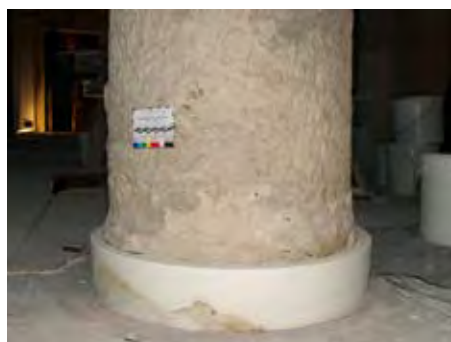
◀ Fertige angearbeitete Säulenbasis
