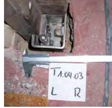
Lagerbolzen eingebaut
