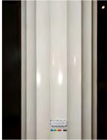
▲ Doppelpilaster aus Marble-Cement. Der linke Pilaster ist neu.
