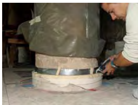
◀ Vergießen der eingerichteten Basis
