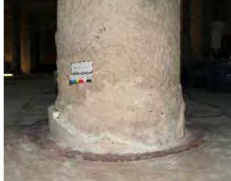
◀ Raum 1.06 Säulenbasis einer Säule aus Marble-Cement. Der tragende Kern der Säulen aus Sandstein bleibt sichtbar, es werden nur die Basen wiederhergestellt.
